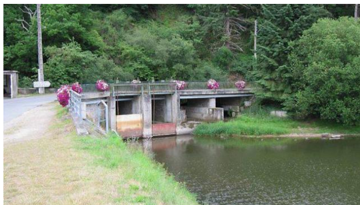
Figure 24 : Système de vannage de l'étang de Jugon avant les travaux (Ouest France – 03/07/13)
