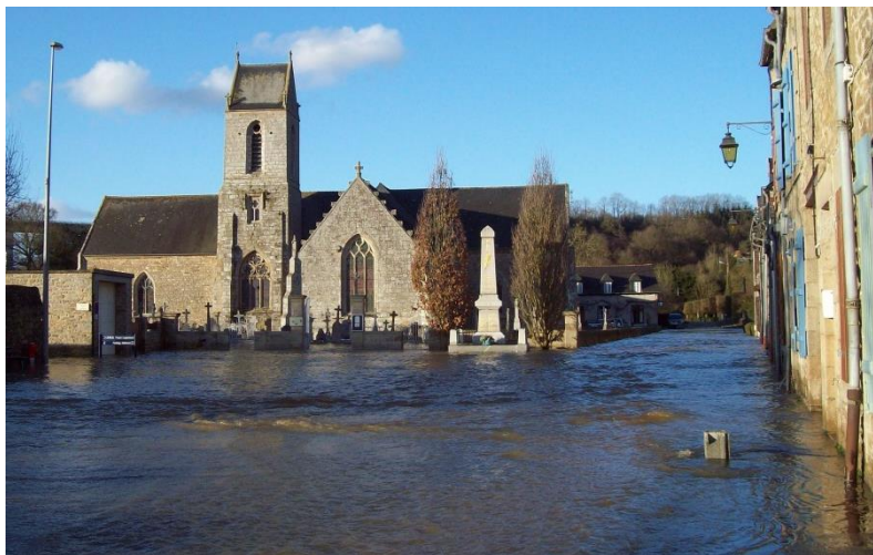
Figure 21 : Eglise Notre-Dame lors de l'inondation de février 2010 à Jugon-les-Lacs
