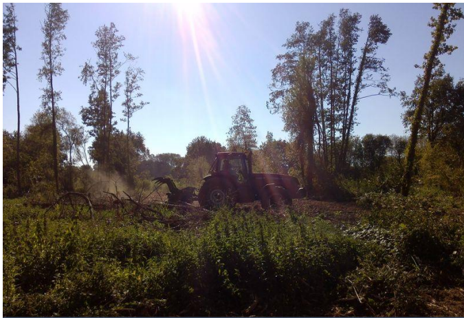
AVANT TRAVAUX – SEPTEMBRE 2015
