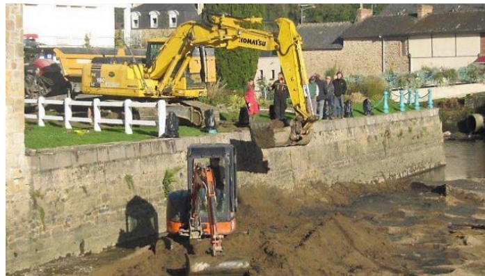
Figure 37 : Travaux de désenvasement de l'Arguenon à Plancoët le 07/11/14 (Ouest France – 10/11/14)
