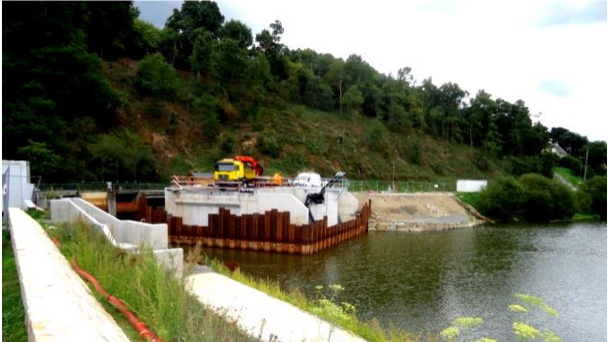
Figure 25 : Vue sur une partie de la digue durant les travaux (04/09/15)
