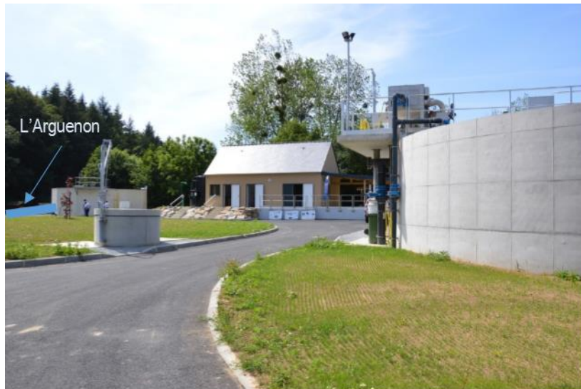
Figure 22 : Station d'épuration de Jugon-les-Lacs
