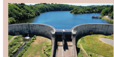
Retenue d'eau sur l'Arguenon située derrière le barrage de la ville Hatte à Pléven
