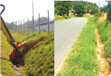
Promotion de nouvelles pratiques d'entretien des fossés, pour sensibiliser aux techniques de curage des fossés permettant de limiter l'érosion et de réduire la vitesse d'écoulement de l'eau dans le fossé. Ici, une méthode de curage en tiers bas du fossé pour préserver la végétation du talus (stabilité et biodiversité préservés).
