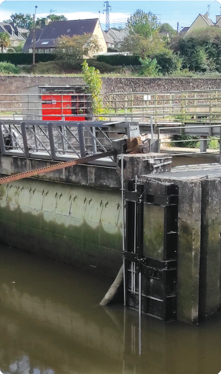
Etude préalable à l'optimisation du barrage anti-marée de Plancoët, pour définir des solutions à mettre en œuvre pour optimiser son fonctionnement.
