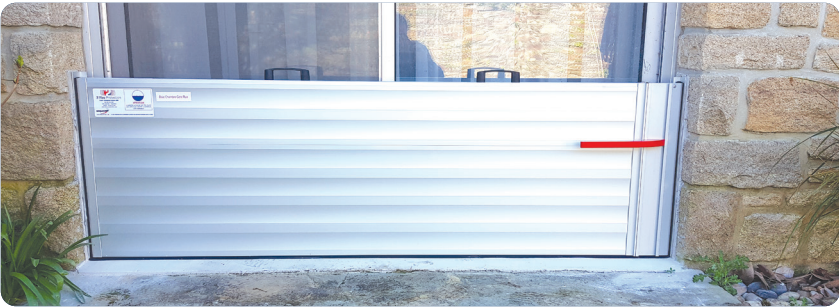
Diagnostics de vulnérabilité des biens d'habitations et des locaux d'entreprises, suivis de travaux de réduction de la vulnérabilité (installation de barrières anti-inondation sur les ouvertures, réhausse de prises électriques, installation de clapets anti-retour sur les eaux usées, ...).
