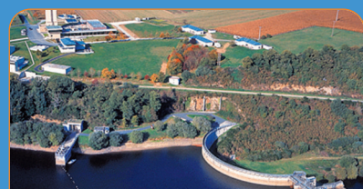
Barrage départemental et usine de la Ville Hatte à Pléven
