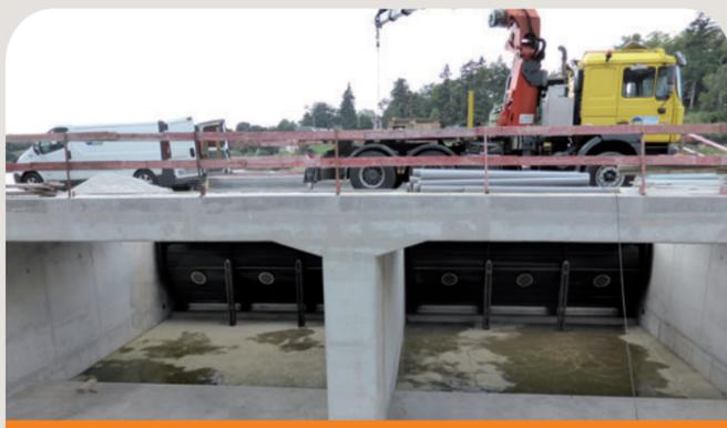
Sur le grand étang de Jugon-les-Lacs, des travaux de réhabilitation de la digue et la construction de clapets hydrauliques ont commencé fin août 2014.
