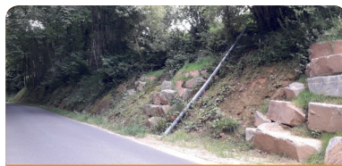
Restauration du talus - Pléven 06/2018
