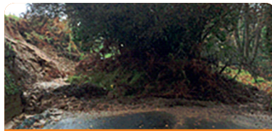
Talus effondré - Pléven 12/2017
