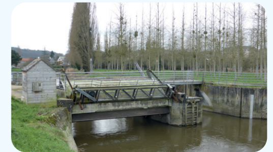
Barrage anti-marée de Plancoët
