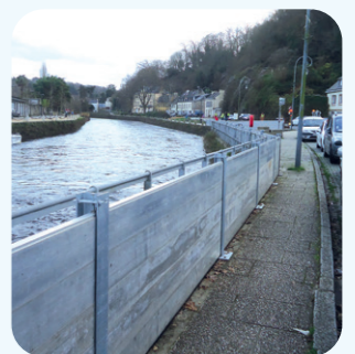
Barrières anti-inondations sur les quais de Quimperlé
