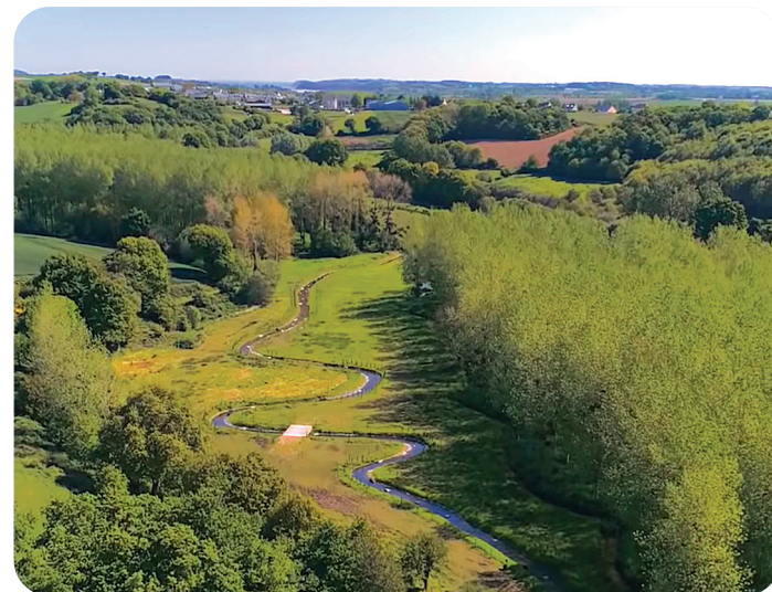
Travaux de remise dans son lit naturel du cours d'eau du Frémur à Pléboulle (1,5km) réalisé en 2019 par Dinan Agglomération.
