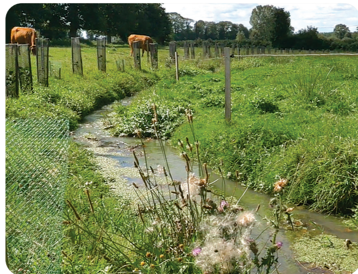
Remise dans son lit naturel et restauration des berges du cours d'eau du Mirbel à Trémeur (1.5km) réalisé en 2020 par Lamballe Terre & Mer
