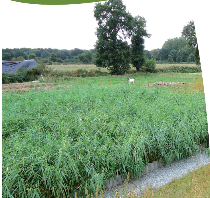
Ici, le principe de filtre naturel des zones humides à été adapté aux besoins humains pour concevoir des lagunes d'épuration des eaux usées plantées de roseaux.
