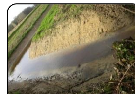
Remise en talweg
