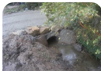
Après travaux Circulation piscicole restaurée
