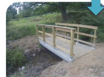
Après travaux Berges restaurées
