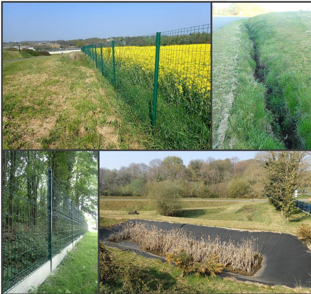
Figure 33 : clôture sans et avec renforcement en béton à la base, fossé végétalisé, bassin bâché avec échappatoire
