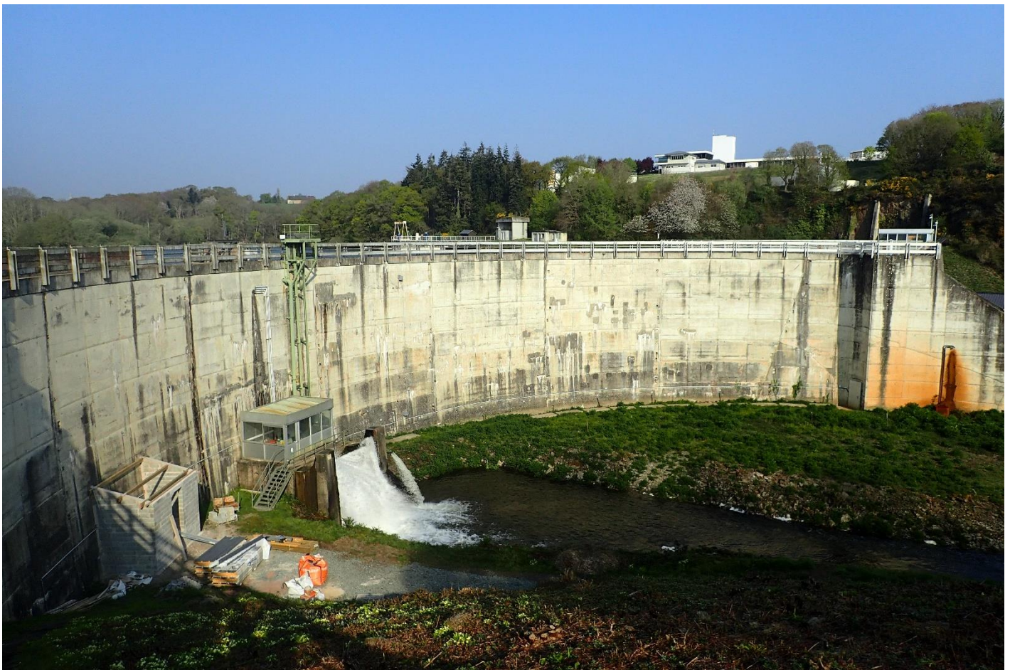
Figure 8: Barrage de la Ville Hatte
