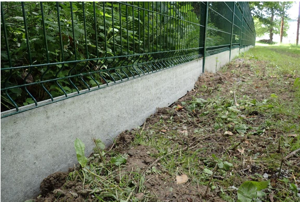
Figure 45 : renfort en béton à la base des clôtures
